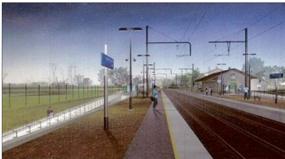
Le souterrain (à g.) permettra de passer sous les voies (SNCF Réseau).
